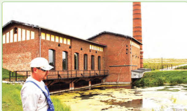
Przepompownia w Kończycach
