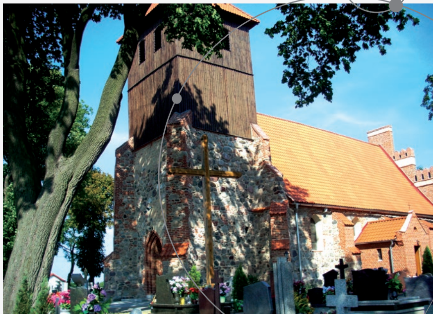
Kościół pw. św. Michała Archanioła, fot. Paweł Marwitz
